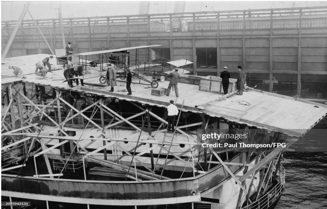
La pista de tablones de madera colocada sobre la cubierta del buque con el avión de Burton Ely
